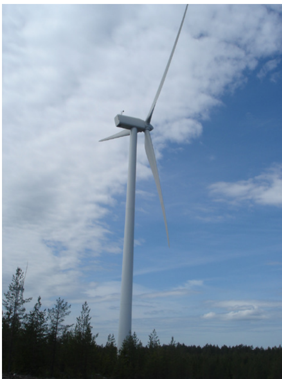
Vindkraftverk i Håcksta vindpark, Hudiksvalls kommun.
