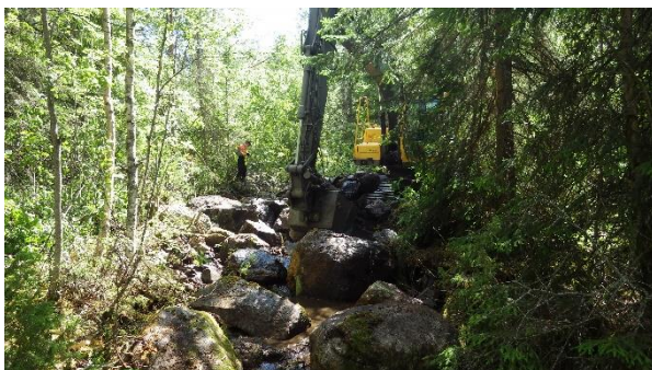
2: Framgrävning av ursprunglig åfåra.
