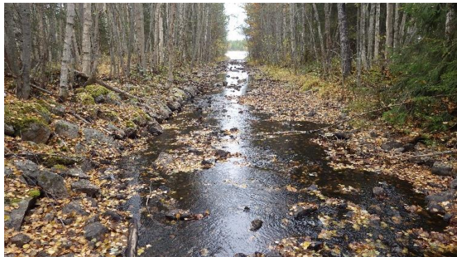
Grävd utloppskanal med Mållången i bakgrunden.
