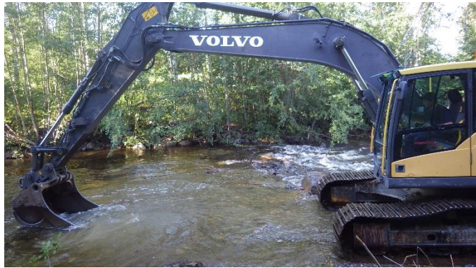
Exempel på anläggning av en större lekbädd för stor sjölevande öring. Väljeån Ljusdal Energi AB 2015.
