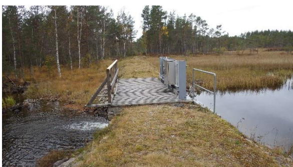
Vattenytan nedströms Tälningssdammen låg enligt våra mätningar vid inventeringen på en höjd av + 230,50 vid rådande minimitappning. Vid full magasinnivå (+231,70) medför detta en fallhöjd på 1,2 m vid denna tappning, samt en fallhöjd på 1,13 m vid 200 l/s. I ett scenario där magasinet är tömt till tappningsgränsen (+230,80) blir fallhöjden 0,3 m om endast 0,100 l/s släpps genom dammen, medan det sannolikt inte förekommer någon fallhöjd alls vid höga flöden
