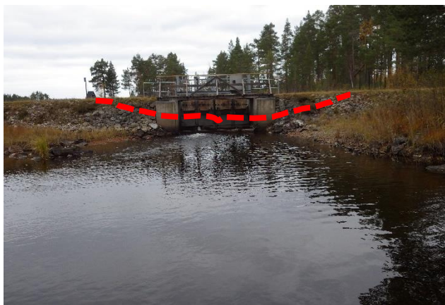
Princip och läge för ny sjötröskel i Tälningen.
