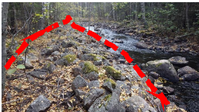
Exempel på en stenvall som avskärmar ursprungliga strandlinje i sträcka C. Lägg märke till hur massorna hindrar vegetationen med dålig kontakt mellan land- och vattenmiljö som följd.
