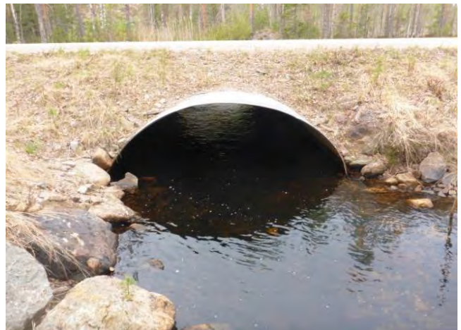
Valvbåge i Älman. Dock saknas det en torr passage för ex. uter genom trumman.
