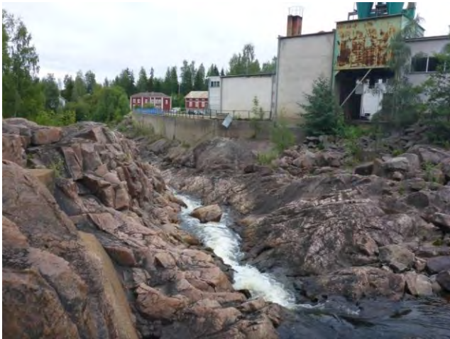
Delvis sprängda hållar i Alftaströmmarna.
