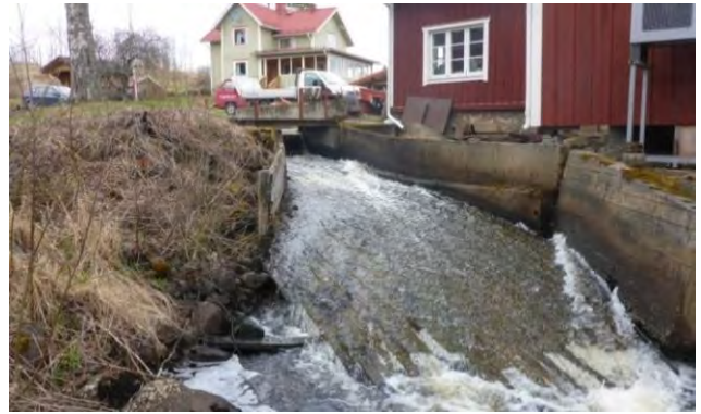
Vh 7. Kraftverksdamm nedströms smedjedammen i Ullungfors.
