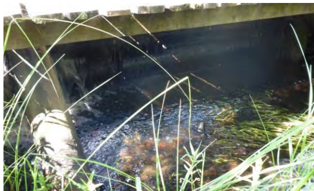
Vh 3. En damm med stockar under en liten träbro.
