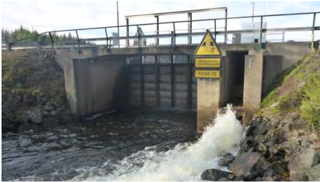
Vh 1. En reglerdamm. Det gjutna utskovet till höger i bild kan vid första anblick tas för en fisktrappa, men det är det inte.
