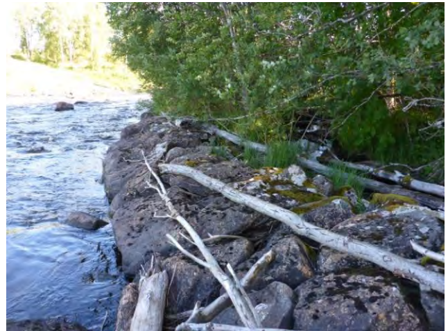
Flottledsvallen i Homnaströmmen som stänger av en mindre orensad sidofåra.
