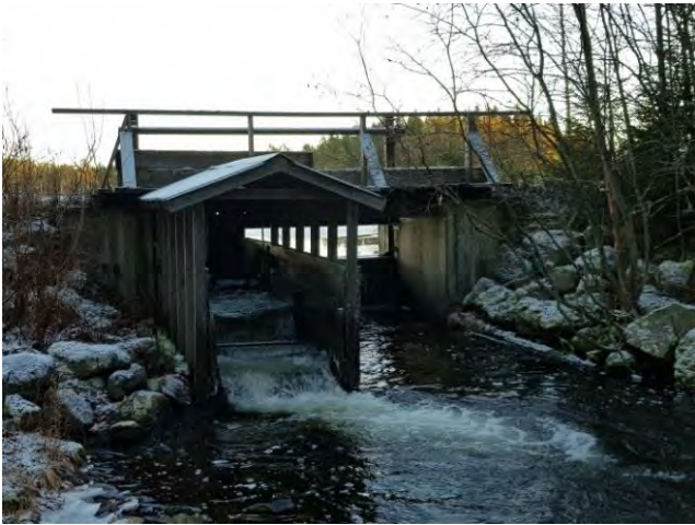
Vh 1. Flottningsdamm vid Stora- Öjungens utlopp.
