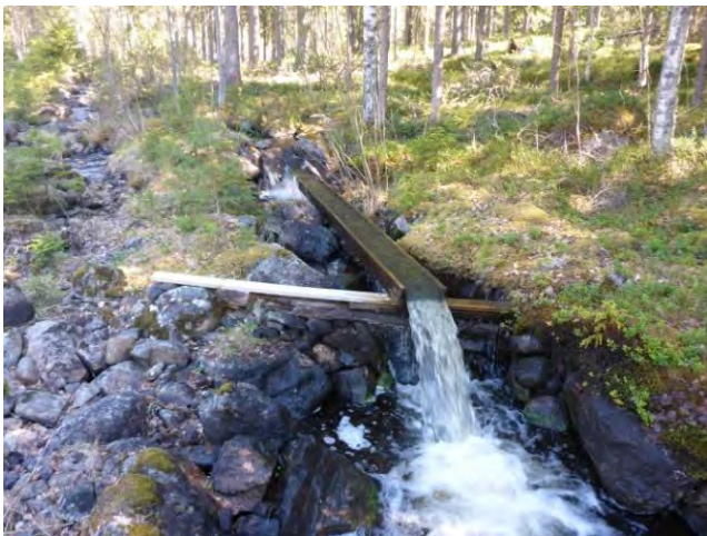
Vh 3. En blockdamm med vattenränna.
