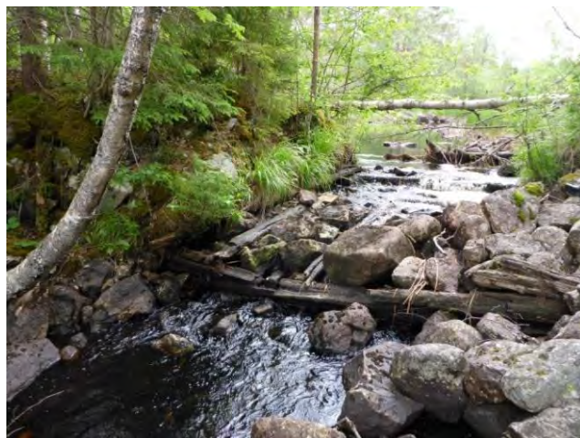
Vh 4, en damm med stockar och block.
