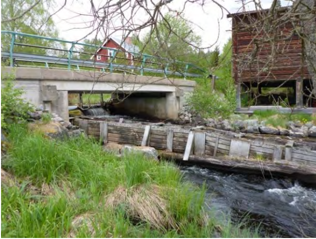
Vh 7. Gammal Flottningsdamm vid Homnabo. Fisktrappan fungerar inte alls.
