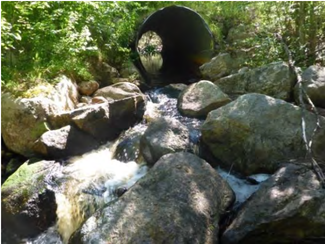
Vh 8, fall över block precis nedströms vägtrumma.
