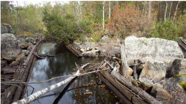
Den öppnade sidofåran till höger i bild.
