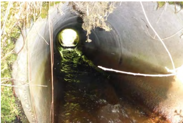
Vh 1. Vägtrumman som vid höga flöden blir svår att passera.
