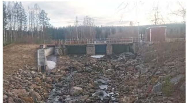
Vh 8. Kraftverksdammen i Frösteboån.
