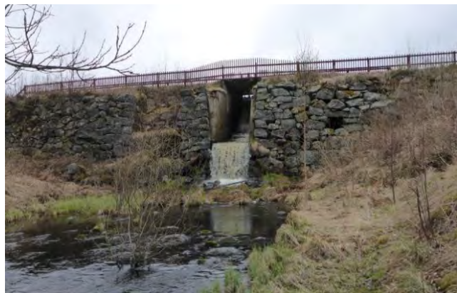
Vh 16. Dammen vid det sydvästra utloppet ur Övre Hammardammen.
