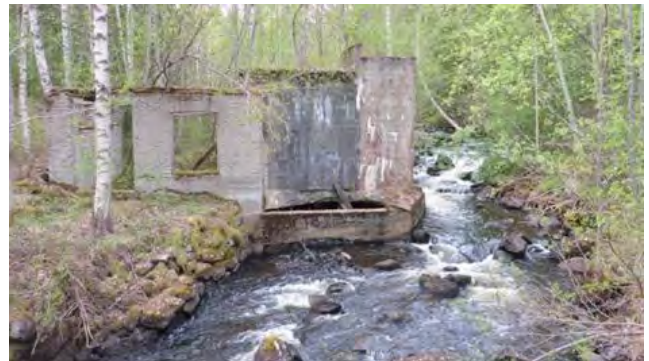
Delvis utrivet kraftverk 1,1 km nedströms sjön Fullen.
