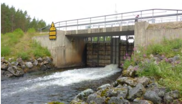
Vh 2. Reglerdamm vid Gryckens utlopp.
