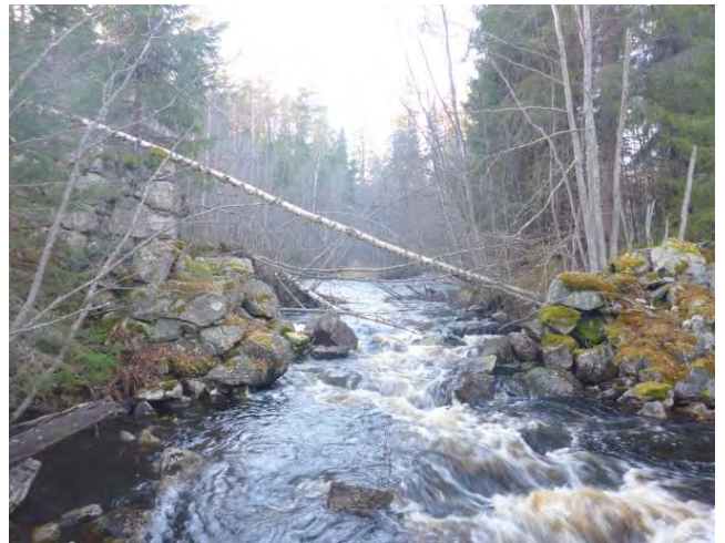
Delvis utriven damm nedströms Stora Båtsjön.
