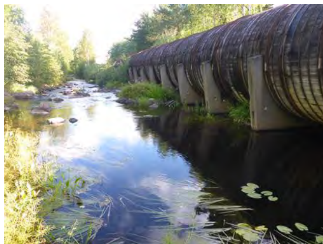
Fin strömnacke strax efter Öjebäcken gått under tuben.
