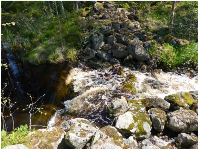
Vh 2. Kvarvarande dammrest som utgör ett partiellt vandringshinder.
