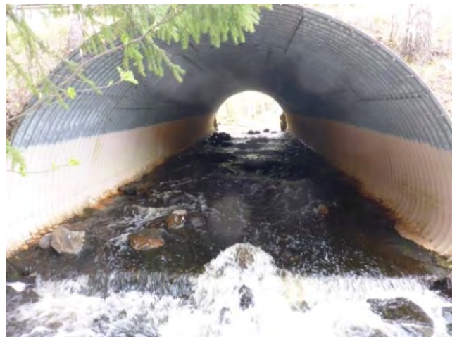
Vh 5. En valvbåge där några stenar har lagts på den släta botten för att bromsa vattnet och underlätta fiskvandring.
