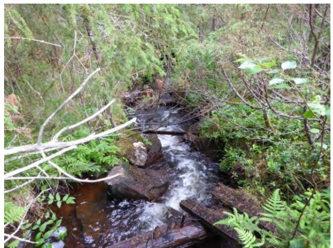
Rensad ström nedströms vägtrumman.
