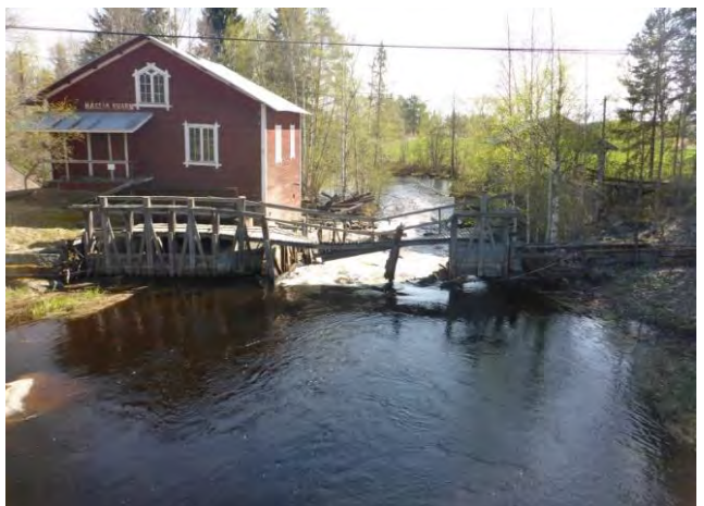
Hässja Kvarn med halvt raserad damm.
