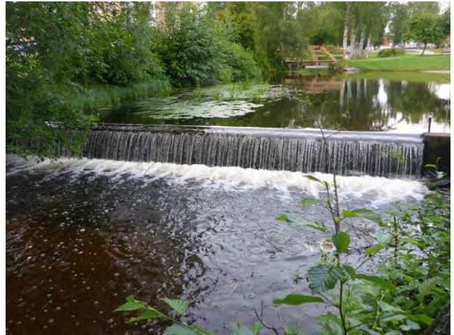
Vh 3. Spegeldamm som utgör definitivt hinder för alla arter. Sträckan uppströms används som badplats.
