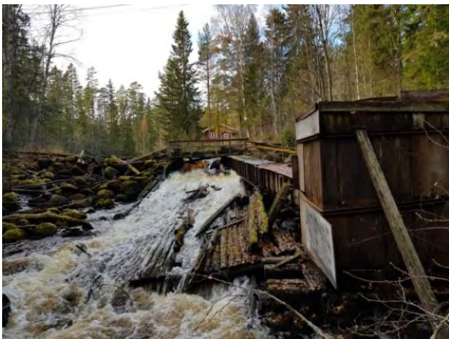
Vh 3. Kraftverk m. tillhörande damm.
