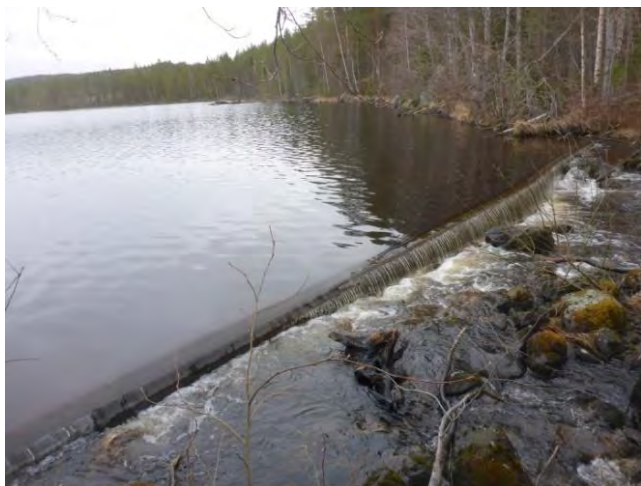
Vh 12. Nivåhållande dammtröskel som finns i Sälmsjöarnas sydöstra del.
