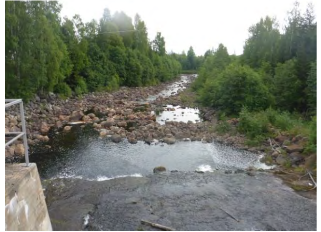
Den 300 m långa torrfåran i Vallhaga. Endast spillvatten från dammen sipprar mellan stenarna.
