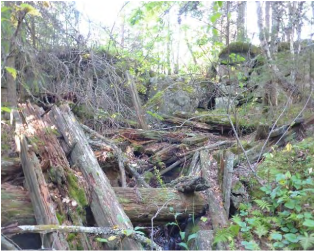
Vh 1. Delvis raserad dammvall i Råkasjöarna där vattnet tränger sig igenom.
