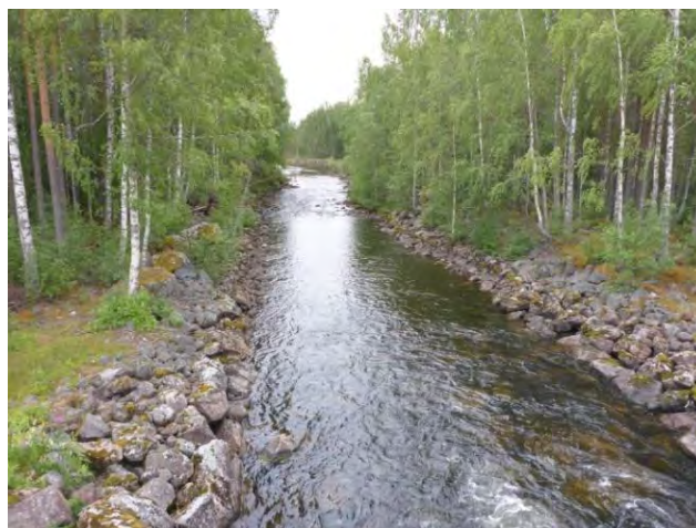
Den grävda kanalen mellan Grycken och Gryckflugen.
