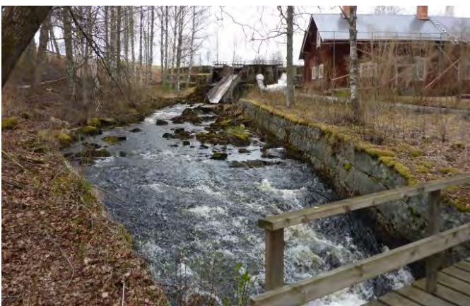
Kanaliserad sträcka med stensatta stränder nedströms sista dammen i Sälmlån.
