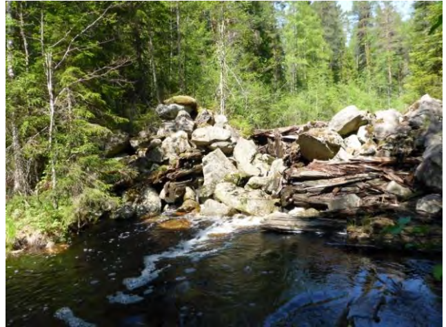
Vh 5. En damm som utgör ett definitivt vandringshinder.
