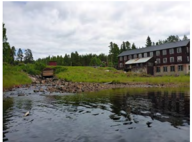
Vh 3. Kraftverksdammen där fåran som tidigare gick till ett sågverk syns tydligt.
