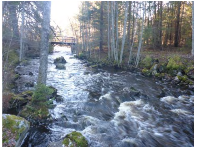
Dåligt utförda biotoprestaureringar nedströms Stora Båtsjön. Notera de kvarlämnade upplagda stenblocken till höger i bild.
