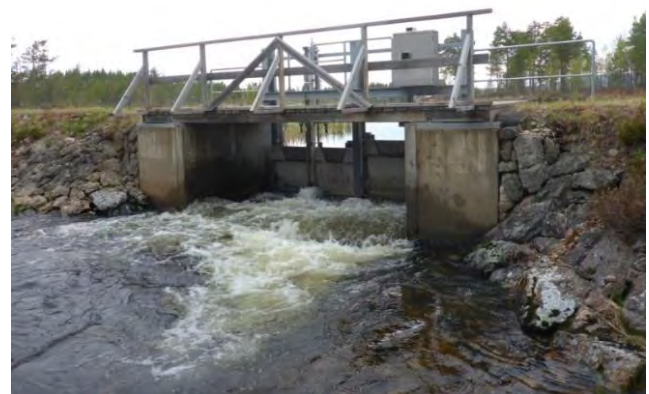
Vh 10. En reglerdamm i Tälningens utlopp.
