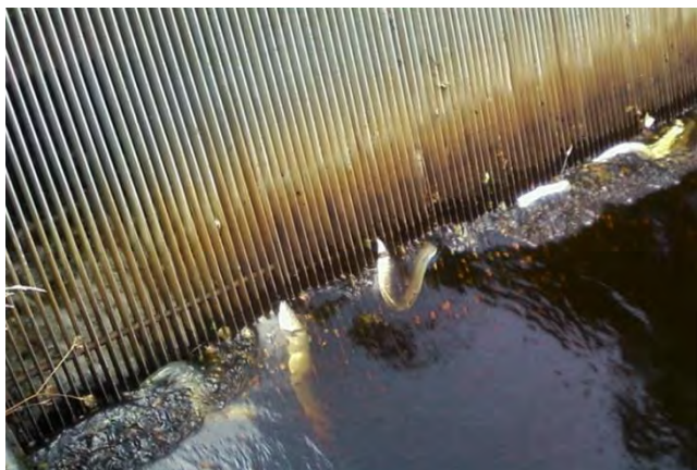
Den utrotningshotade ålen ihjälklämd i ett galler till en kraftverkstubb. Foto: Älvräddarna
