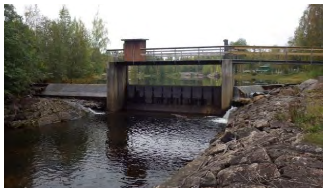
Vh 13. Regleringsdamm strax nedströms Forsparken i Alfta.
