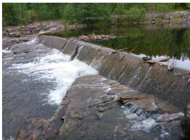
Bild på 1 av totalt 9 st. spegeldammar längs Alftaströmmarna i Voxnan. Dessa dammar utgör vandringshinder och fyller ingen annan funktion än att dämna vatten enbart för landskapsbildens skull.
