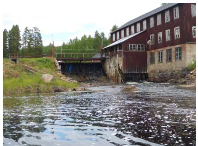
Vh 3. Kraftverksdammen, med fisktrappan till vänster och turbinvattnet till höger i bild.
