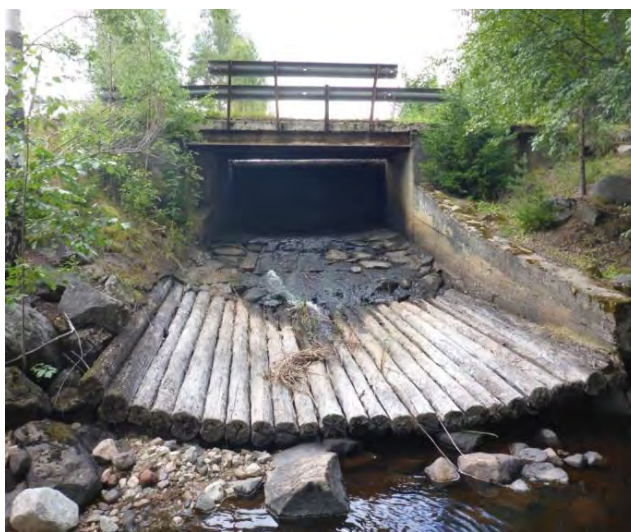
Bild på kraftverksdammen i Torrbergsbo, Hässjaån. Anläggningen saknar vattendom (Länsstyrelsen Gävleborg).
