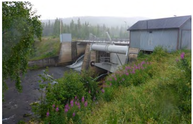
Vh 2. Kraftverksdamm i Vallhaga
