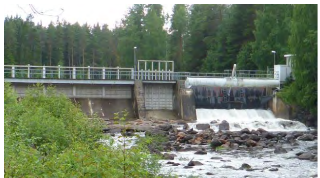
Vh 3. Kraftverksdamm i Bornforsen. Det finns ytterligare två fåror med hinder till vänster om dammen på bilden.
