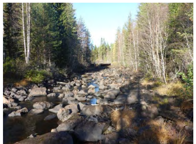
Torrfåran nedströms samma kraftverksdamm. Endast läckvatten sipprar mellan stenarna.
