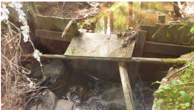
Vh 2. Trädamm 60 m uppströms väg 296/301.
