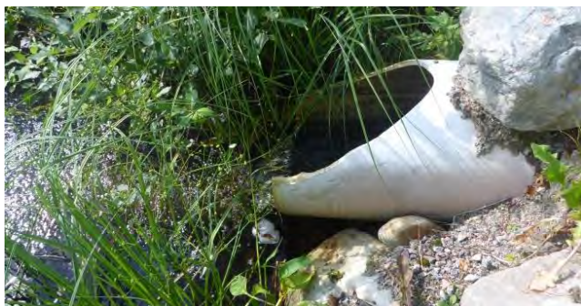
Vh 2. En för smal vägtrumma med fall.
