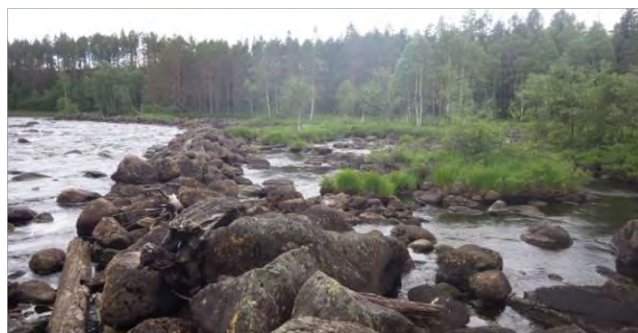
En 200 m lång flottledsvall i sista strömsträckan av Hylströmmen. Notera hur vallen stänger av en stor del av älvbredden och hindrar vattnet från att svämma ut, samt hur det påverkar strömshastigheten. På vänster sida finns ytterligare en vall som också den stänger av ett stort område.
