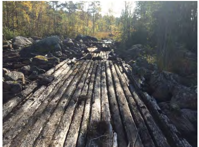
Strömmen näst närmast Tälningen med flotträna över hela fåran.
