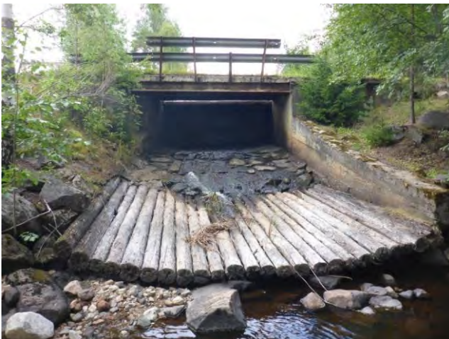
Vh 8. Kraftverksdammen i Torrbergsbo. Definitivt vandringshinder.
