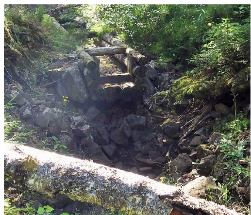
Delar av den provisoriska fiskvägen vid Nederbergsdammen. Foto: Peter Hallgren.
