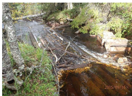
Flotränna uppstr. Gruvbergsleden. Foto: B Nääs.
